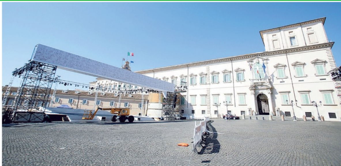
▲ Lavori in corso Il montaggio del palco sulla piazza del Quirinale
